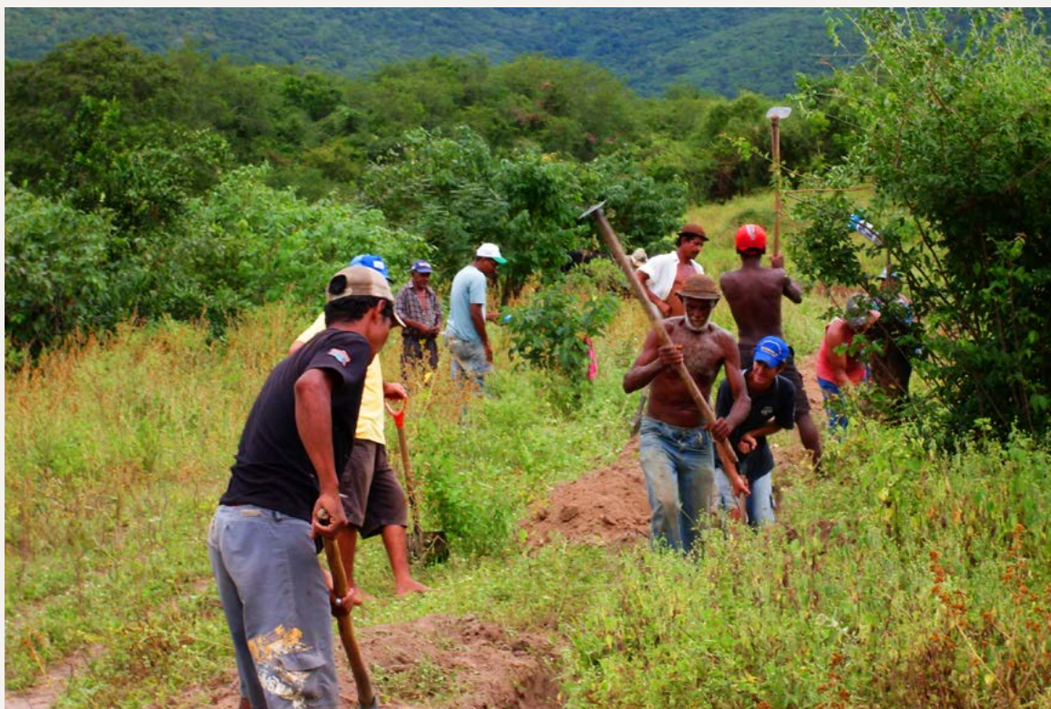
Projeto de Assentamento Transval, em Jequitinhonha/MG, durante abertura de vala para tubulação de água. Foto: arquivo pessoal do autor.
