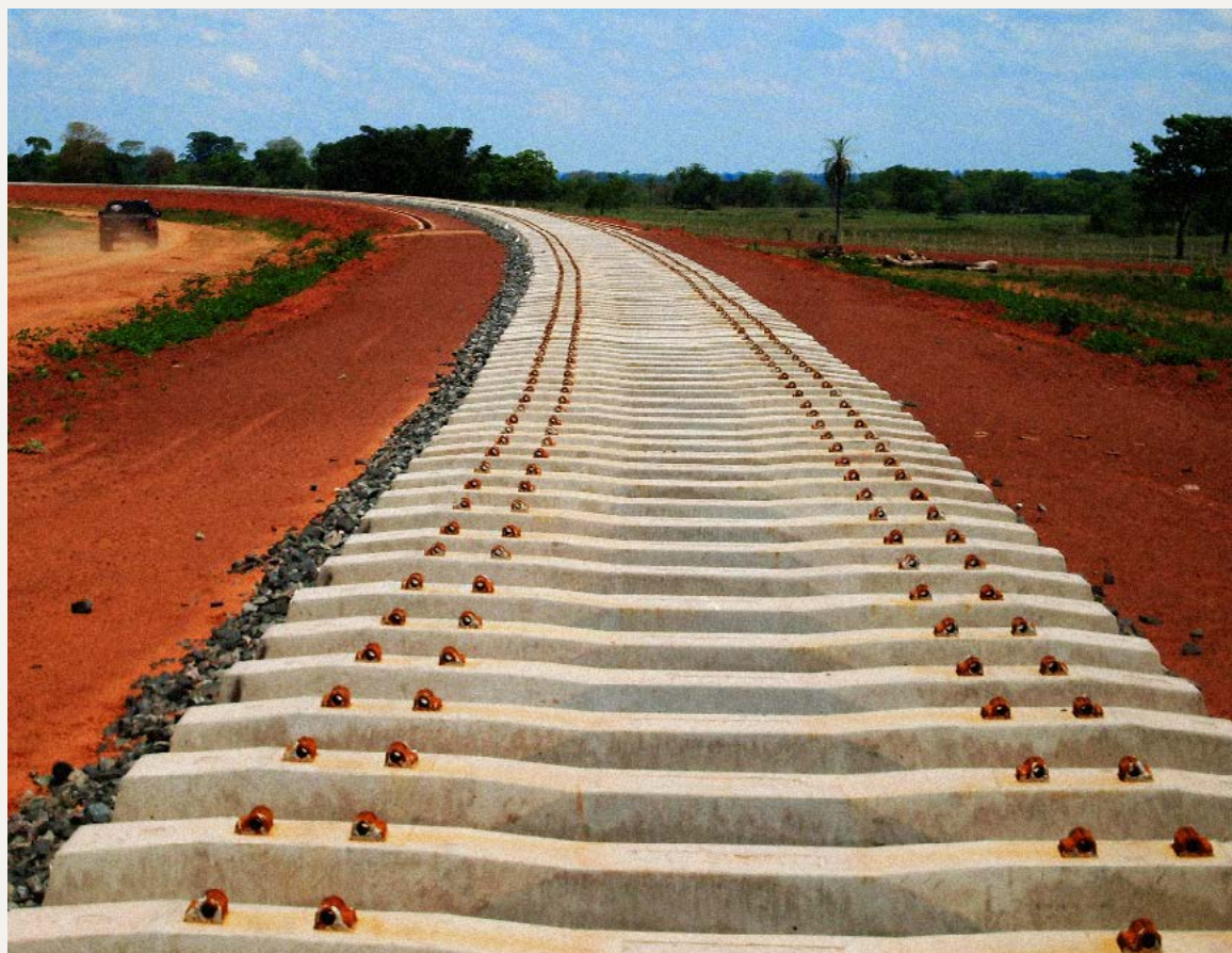
Ferrovia Norte Sul em construção, atingindo áreas de projetos de assentamento do Incra no Triângulo Mineiro. Foto: arquivo pessoal do autor.
