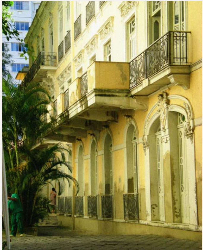
Lateral do prédio. Foto: Miguel Alves Pedro Cardoso.
